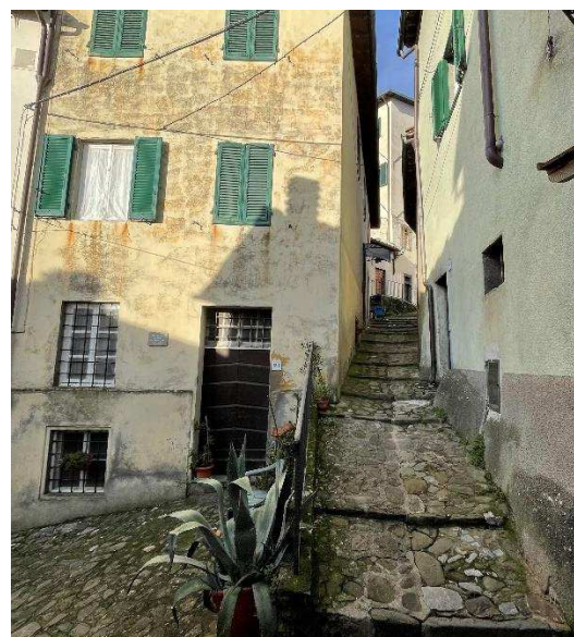
Coreglia Antelminelli – un percorso nel centro storico dove sarebbe ipotizzabile l'installazione di corrimano alle pareti
