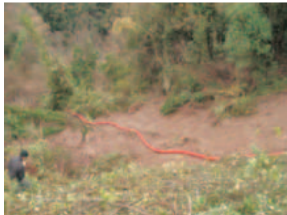
Frana della scarpata di valle lungo la via per Lucignana, al cimitero.
