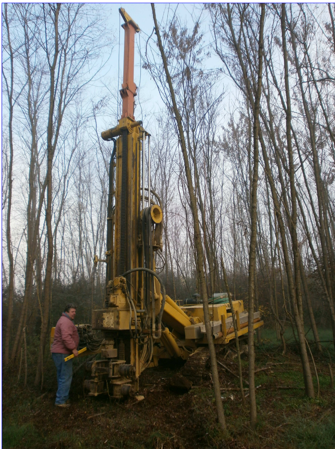
SONDAGGIO - S1- PIANO DI COREGLIA
